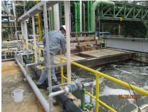
บ่อฟักน้ำทิ้ง บ่อที่ 1 ขนาด 250 ลูกบาศก์เมตร
